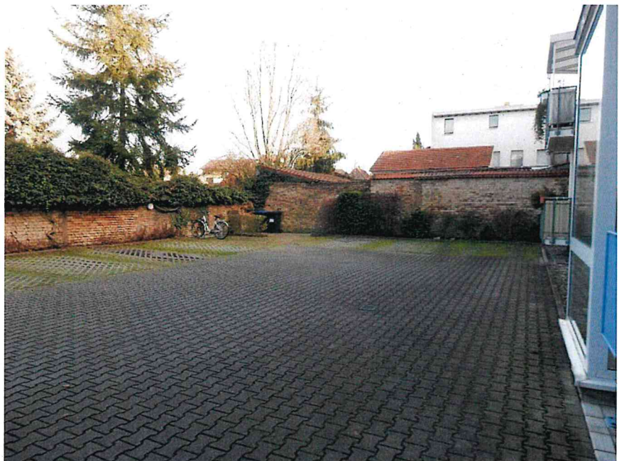
Foto 2 Als Parkplatz genutzter versiegelter Innenhof von Werderstraße 3 (Flst.-Nr. 84/1)
