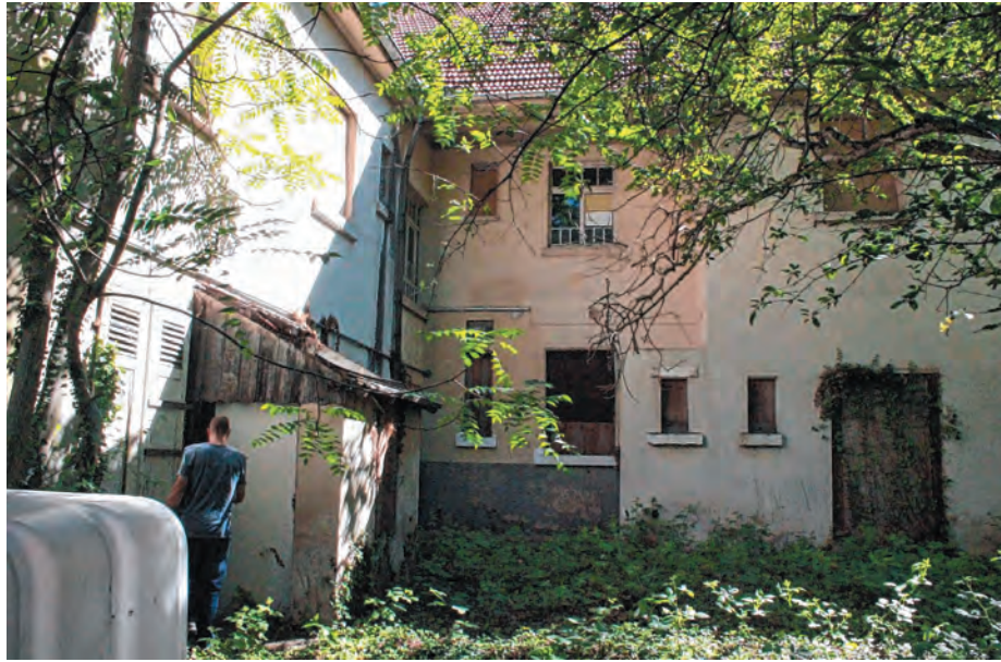
Im Dornröschenschlaf: Seit 2003 steht das Rothackersche Haus – das Bild zeigt den Innenhof – leer. Rund neun Millionen Euro werden für die bevorstehende Sanierung veranschlagt. Bilder: Archiv/oh
